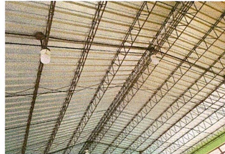
Foto 4: Remozamiento de sistema electrico
