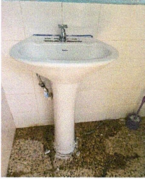
Foto 1: Remozamiento de servicios sanitarios
