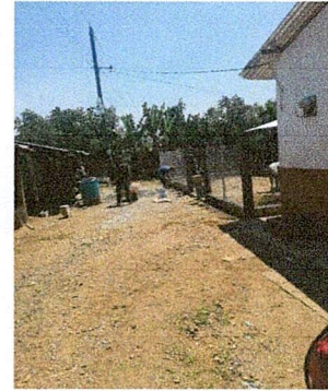
Foto 2: Remozamiento de muro perimetral
