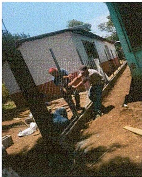
Foto 3: Remozamiento de muro perimetral
